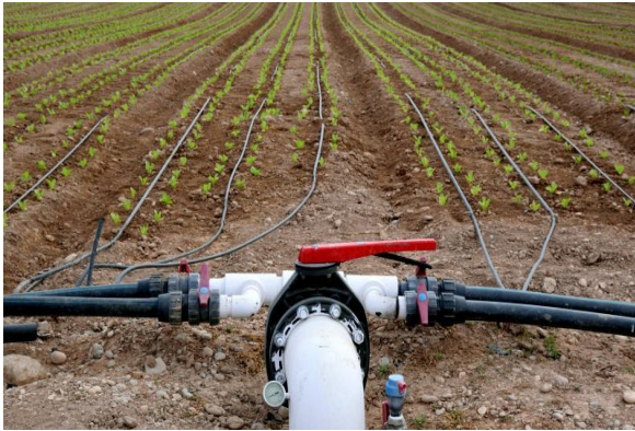
الشكل (2): مكونات شبكة الري بالتنقيط
